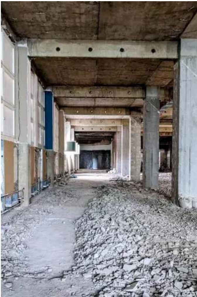
Abriss-Arbeiten, 2022 Foto: © Kunstpalast
